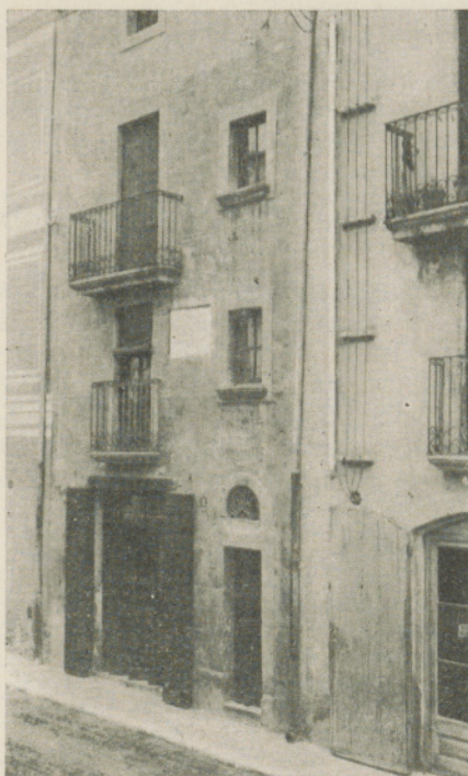
Casa del carrer de Santa Anna, al Vendrell, on va néixer Pau Casals. La làpida que s'hi veu entre balcó i finestra, ho indica.
